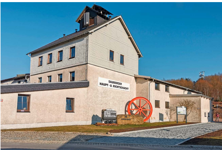
Sauberg Haupt- und Richtschacht in Ehrenfriedersdorf
