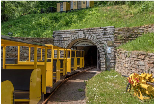
Mundloch am Markus-Röhling-Stolln in Annaberg,
